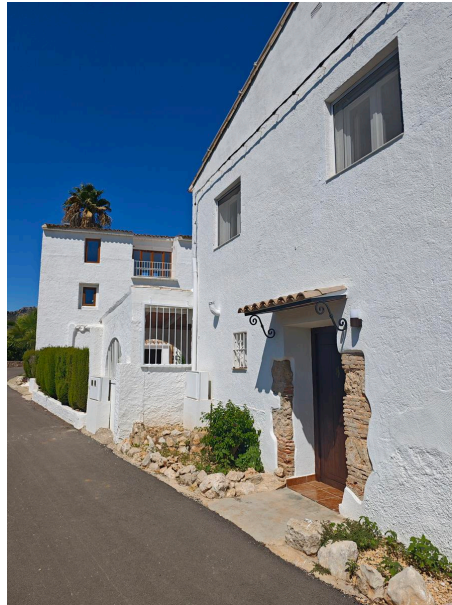
Actual habitatge sobre el molí del Mig. Foto de Valencia Bonita
